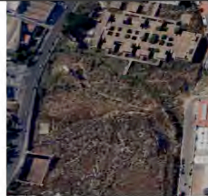
3_ESTRUCTURA ABANDONADA S.XX Área de oportunidad. T.M. Huércal de Almería
